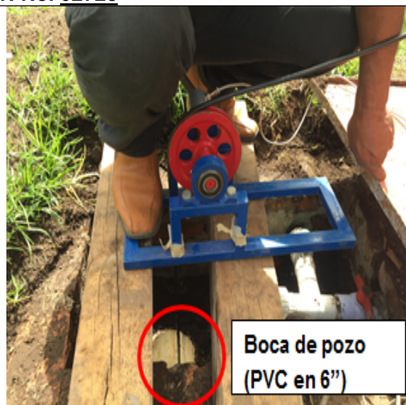
Fotografía 4. Polea utilizada para descender cámara al interior del pozo.
